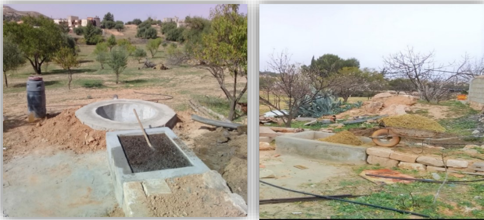
الشكل (12) يوضح عملية تعبئة المخمر.
