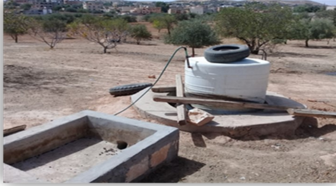
الشكل (13) يوضح شكل المخمر بعد تركيب الخزان.
