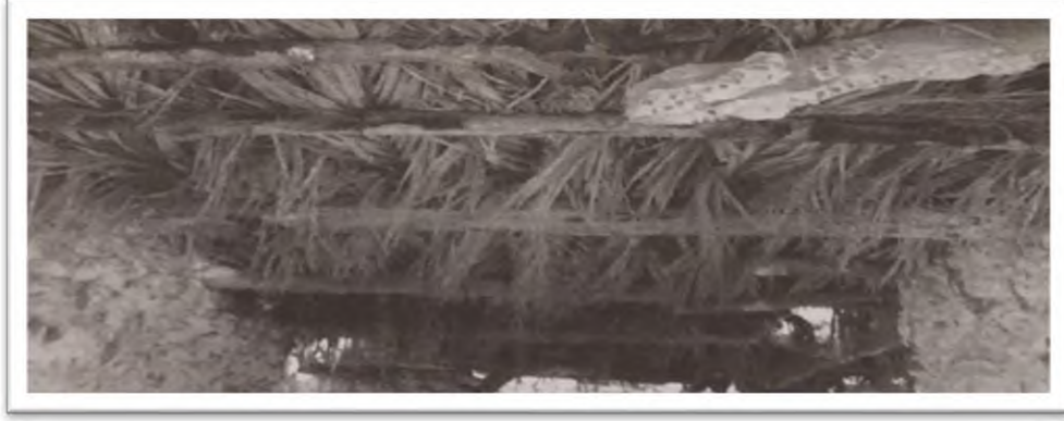
الشكل رقم (10) يوضح كيفية اخشاب النخيل والأثل في البناء .
