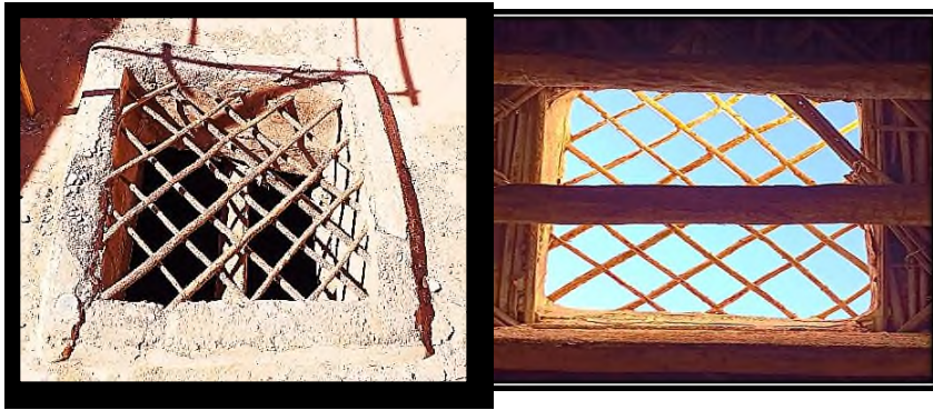
شكل رقم (16) صورة مقربة لشكل فتحة الإضاءة والتهوية (تنفوت) الأولى على اليمين من تحت
