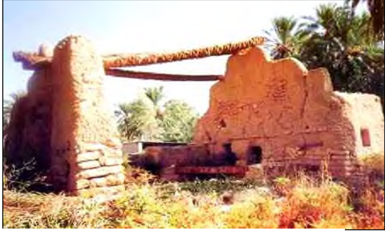
شكل (12) استخدام النخيل والطوب والطين لاعد مباني مدينة سدوس الصحراوية (الغناي، 2010)
