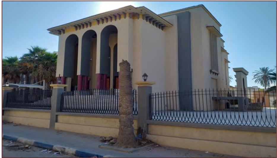
شكل (3_3) الواجهة الرئيسية لمبنى البلدية. تصوير الباحث
