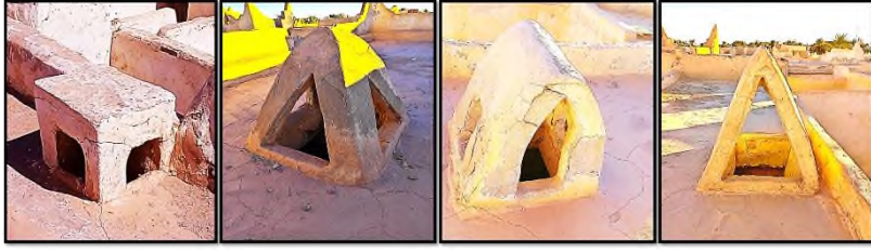
شكل رقم (26) صورة توضح نماذج بعض المداخل الموجودة أعلى مطابخ المدينة القديمة.
