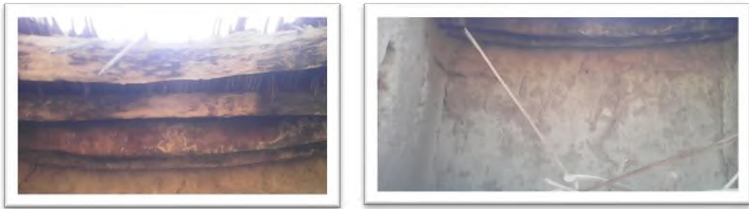
الشكل رقم (8) يوضح أسقف مباني القرية.
